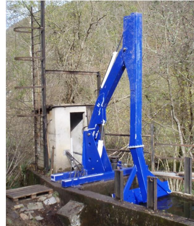
Dégrilleur hydraulique type Pelle
