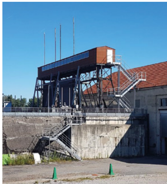
Local manoeuvre en Corten Lg 24 ml Hauteur /sol 11 ml
