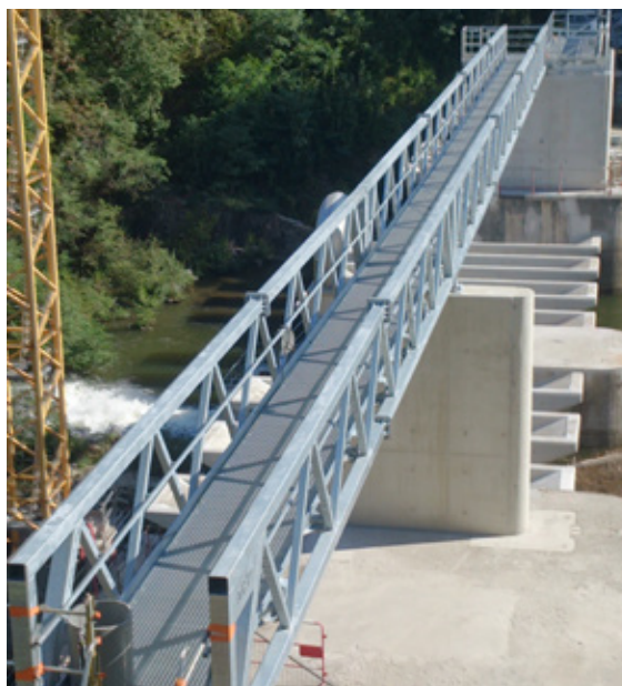
Passerelle 45 ml / 34 ml de portée entre poteaux
