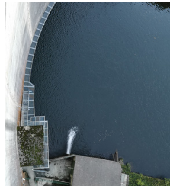
Passerelle d'accès pied de barrage des Cammazes
