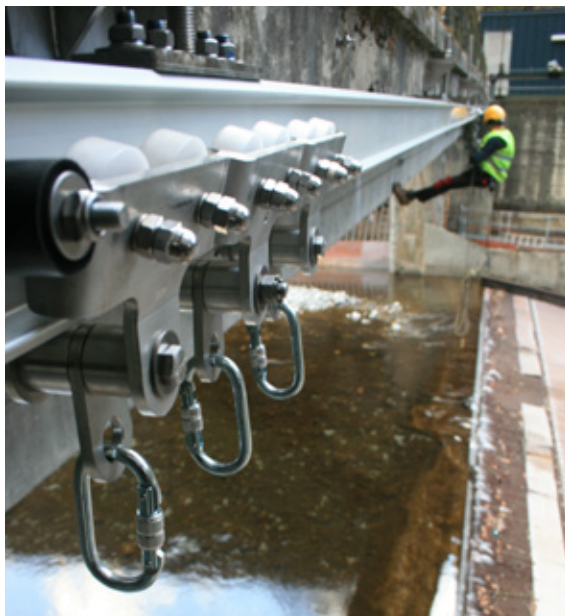
Sécurisation Individuelle par rail dimensionné pour la suspension
