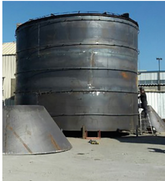
Cuve liqueur noire Ø 7ml Hauteur 17 ml
