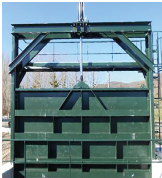
Vanne de garde 3 x 5 ml Motorisation vérin
