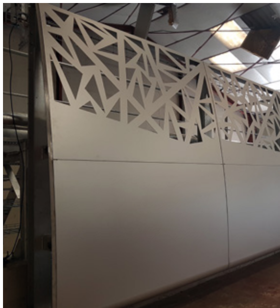
Passerelle technique d'accès Prototype métro Toulouse
