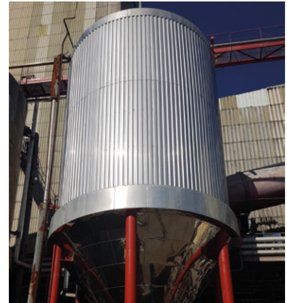
Cuve liqueur noire Ø 7ml Hauteur 17 ml
